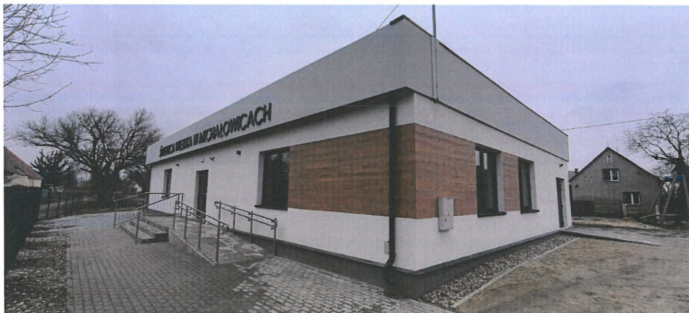
Sala wiejska po remoncie.
