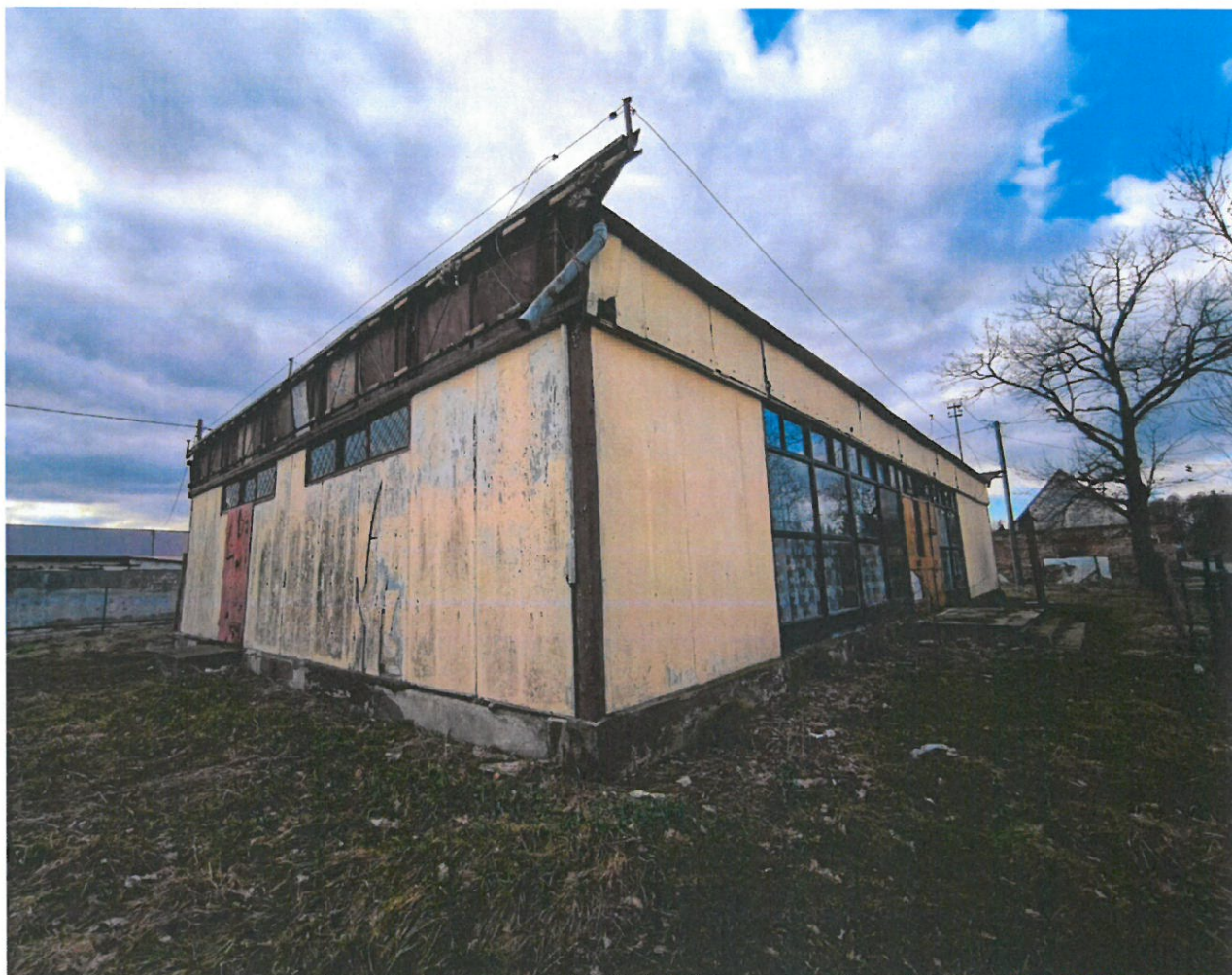
Sala wiejska przed remontem.
